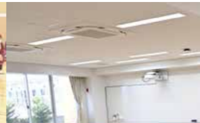
壁のない教室
